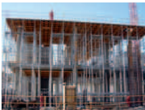
Encofrado Horizontal CC-4 apeado con Cimbra ALUPROP en la Ciudad de la Cultura en Santiago de Compostela, España
