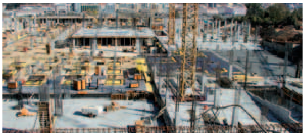
Encofrado CC-4 Panel apeado con Puntal ALUPROP en Forum Coimbra, Portugal
