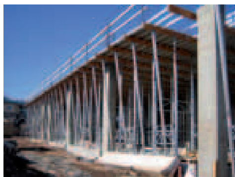
Encofrado CC-4 Ply apeado con Puntal ALUPROP en Edificio Residencial Carriage City en Elizabeth -New Jersey-, EE.UU
