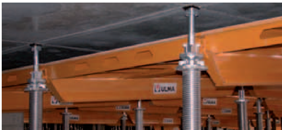
El cabezal de caída hace descender 15 cm el encofrado, facilitando un desencofrado seguro
