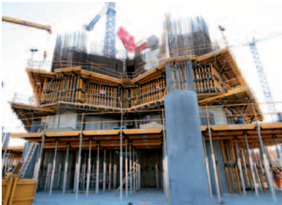
Encofrado Horizontal CC-4 en la Torre S y V, Madrid, España
