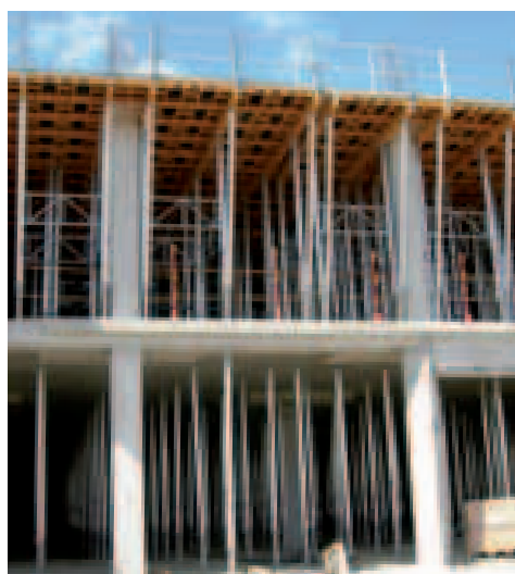
Centro comercial RENOMA en Wrocław, Polonia, ejecutado con CC-4 Panel y Puntal ALUPROP
